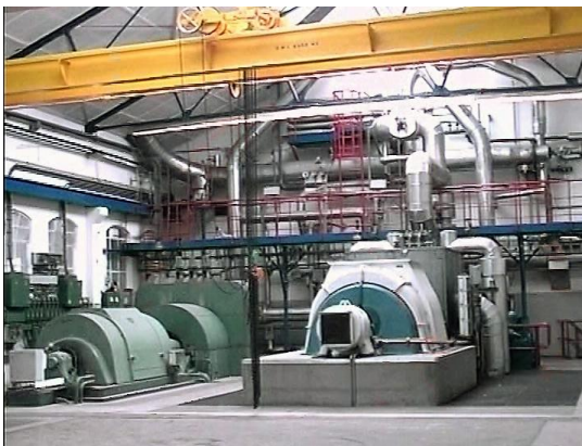
Foto van de stoomturbine
