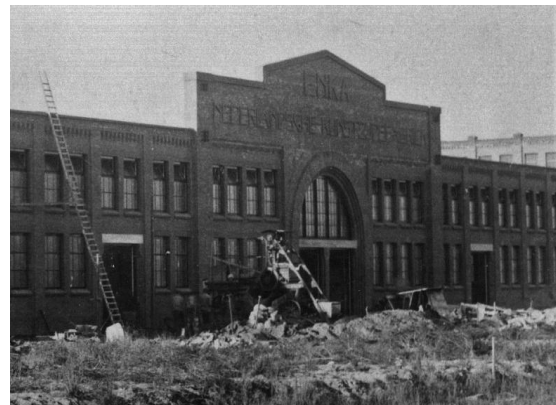
Uitsnede van een foto uit 1925 tijdens de bouw van de uitbouw.
