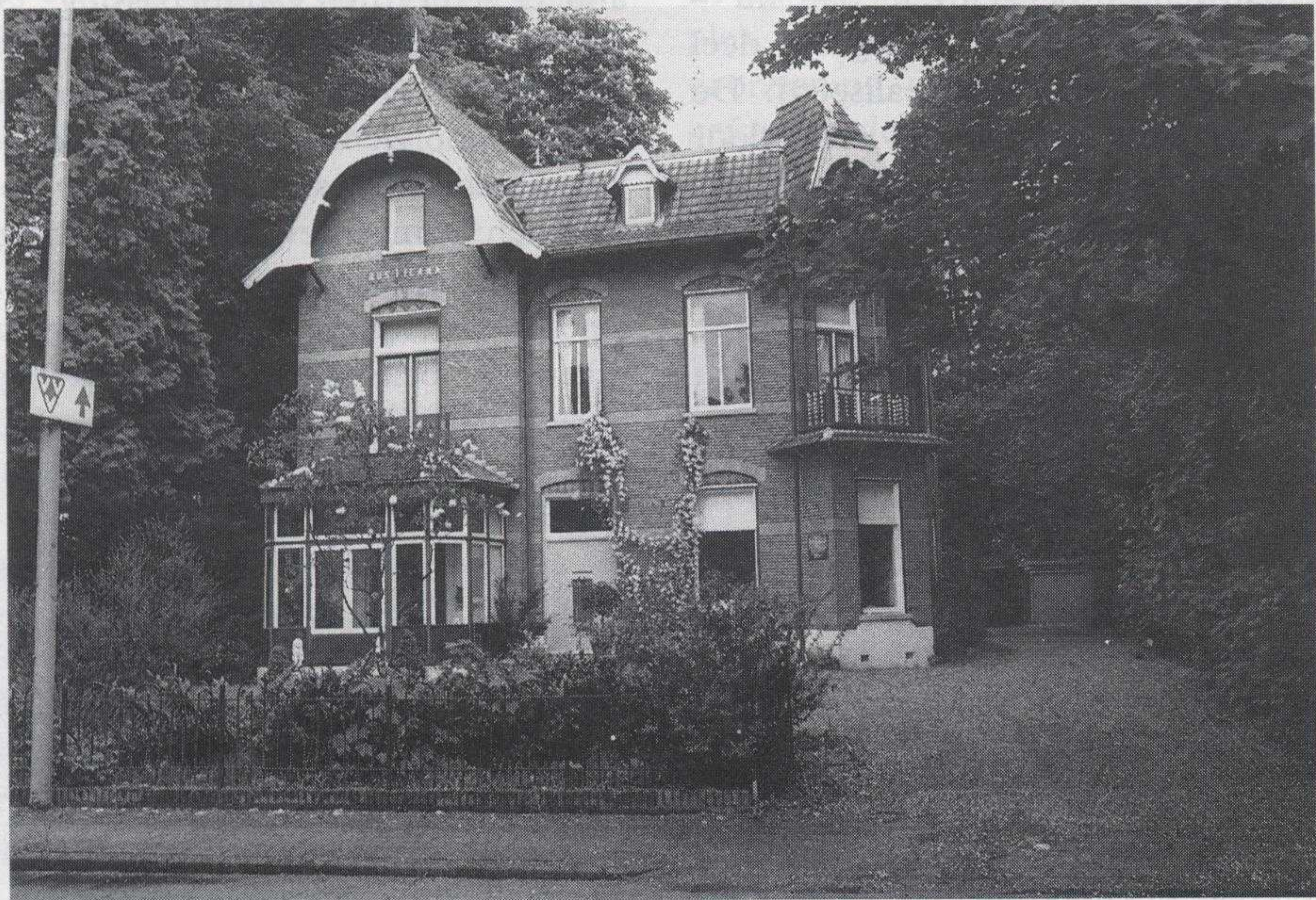
Voorkomen werd dat de slopershamer neerdaalde op de villa Rusticana aan de Bovenweg in Bennekom. (Foto: T. Andeweg)
