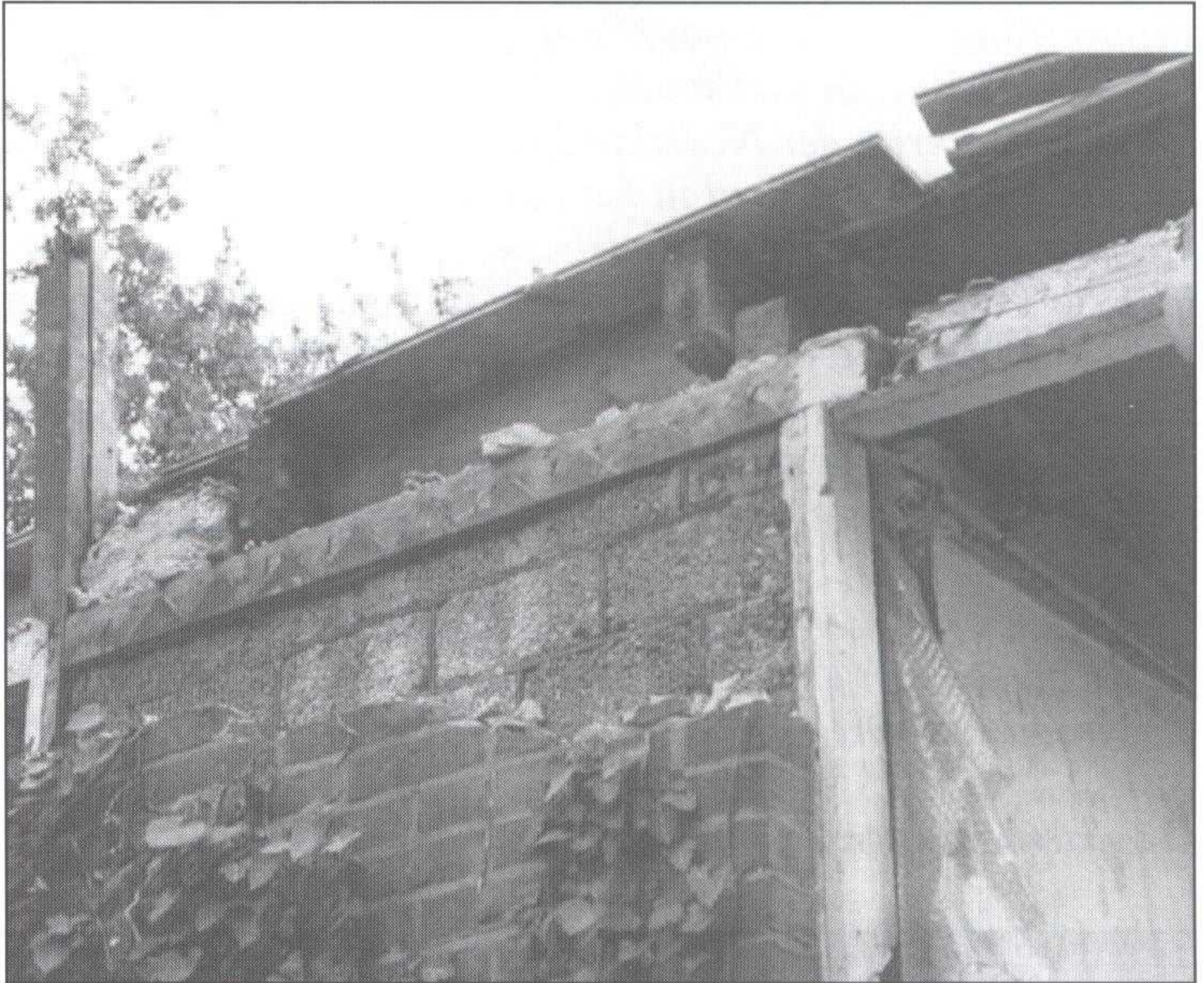
Bij de sloop bleek de binnenmuur de vroegere buitenmuur te zijn.
