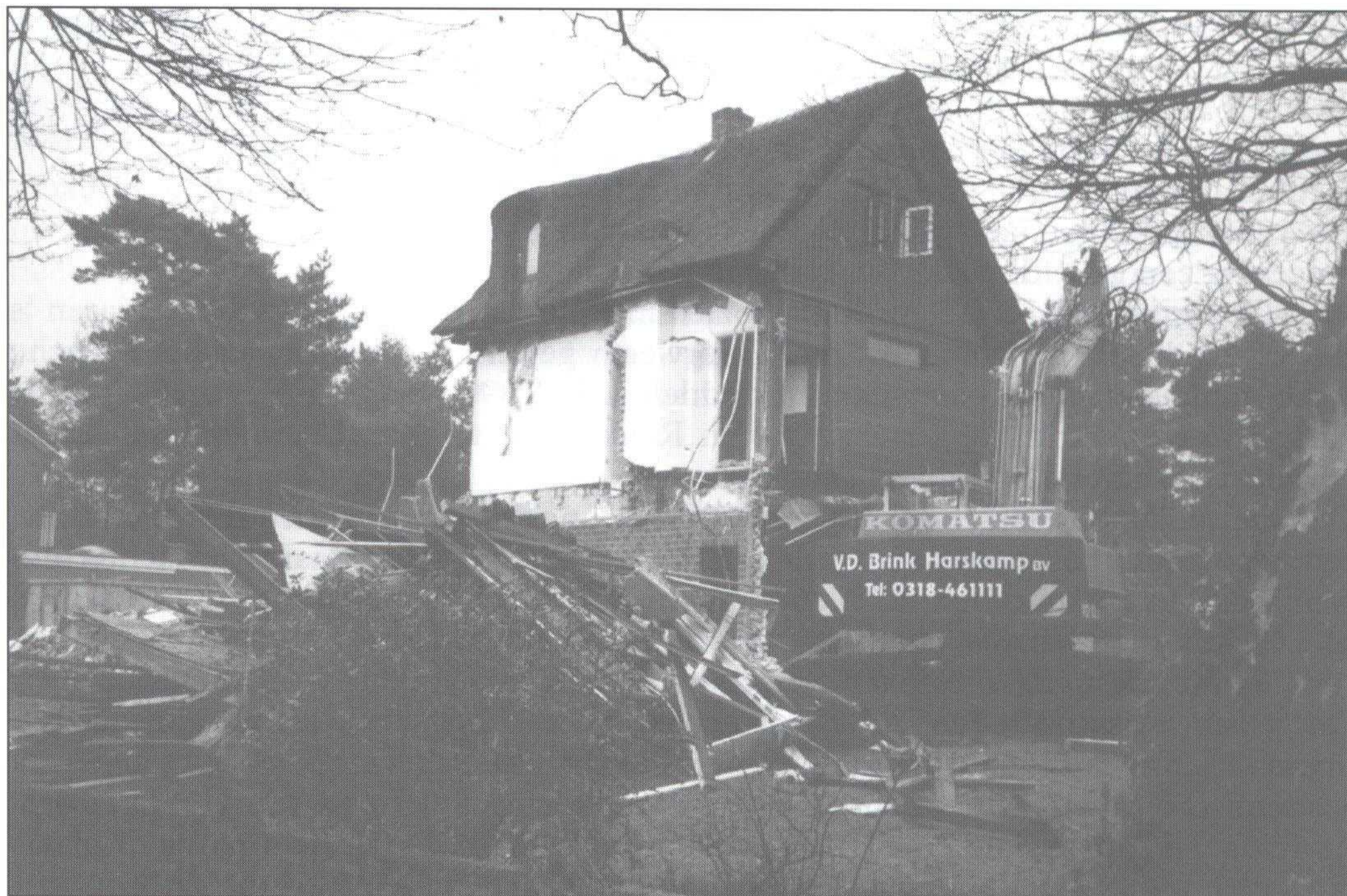
In de loop van 2005 is de woning gesloopt.
