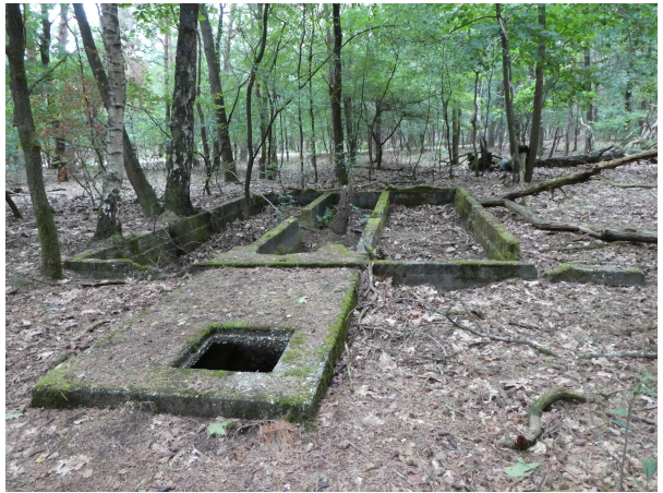
Illustratie 4: Fundamenten van wasgelegenheden
