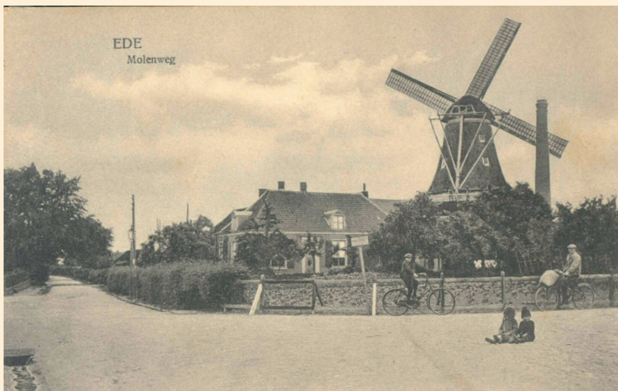
De Molenweg/Molenstraat, gezien in westelijke richting. Rechts de Concordiamolen met de molenarswoning. De weg op de voorgrond van links naar rechts is de Telefoonweg.
