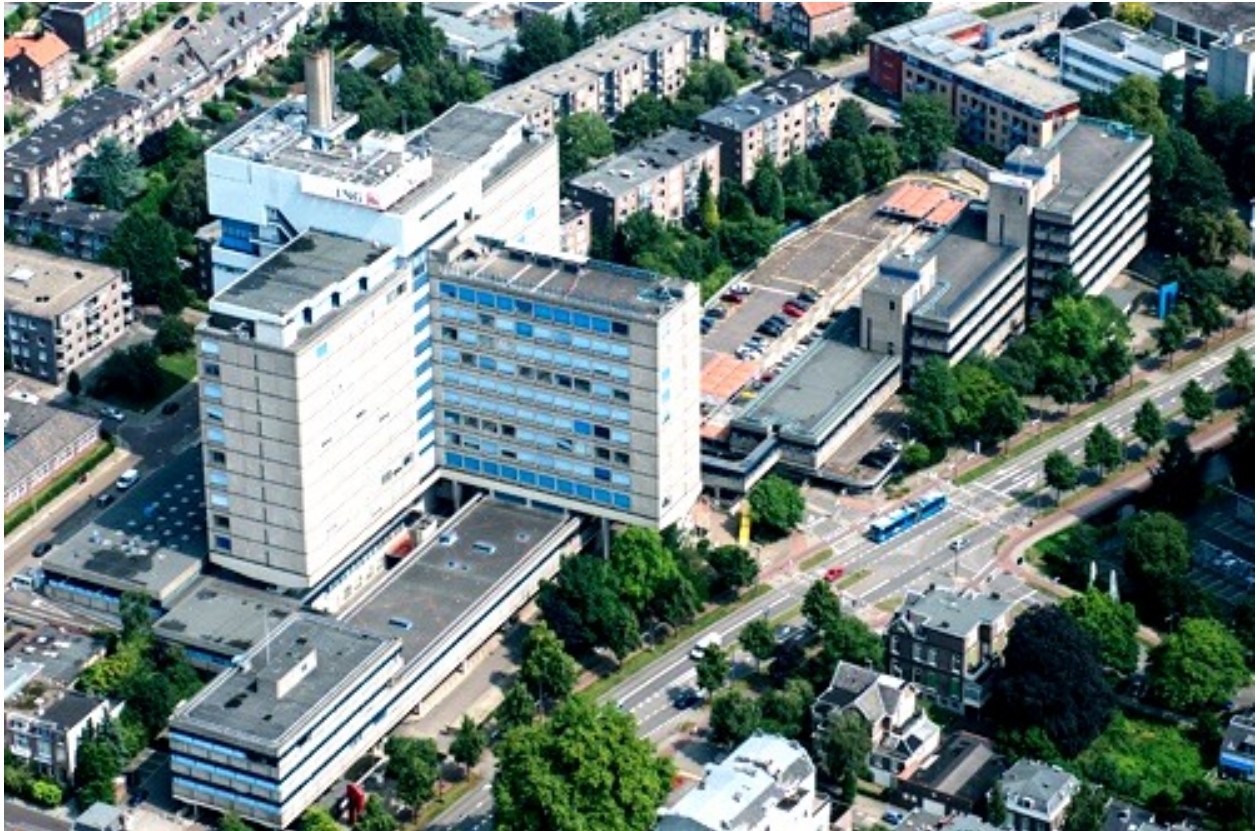
Gebouwen: Girokantoor Arnhem Architect: Broek en Bakema
