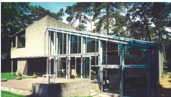
Zuidgevel na verbouwing
