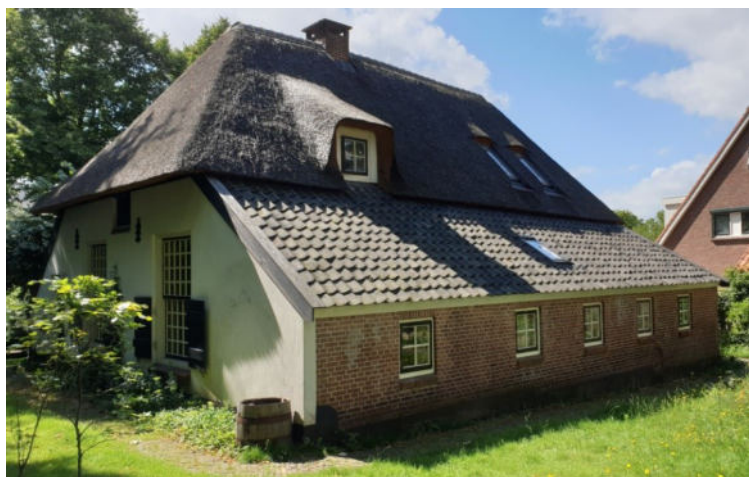
Zadeldak met wolfseinden gedekt met riet en dakpannen
