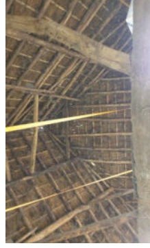
constructie kap met wolfseinde
