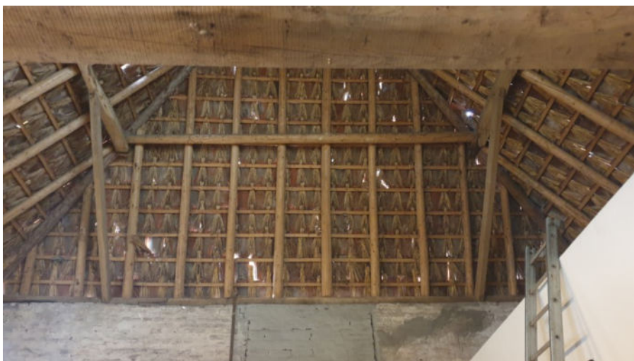
2023: kap constructie voormalige hooizolder en de strodokken
