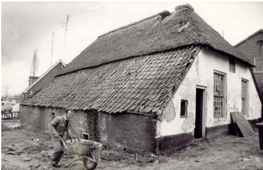
Rechts onderaan de zuidmuur is nog de waterafvoer zichtbaar.
