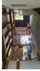
gebint en verdieping balklaag op de deel van boerderij
