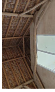
zolder met gebint en deels niet beschoten kap
