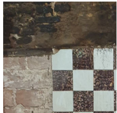
Voorzet muur voor brandmuur.
