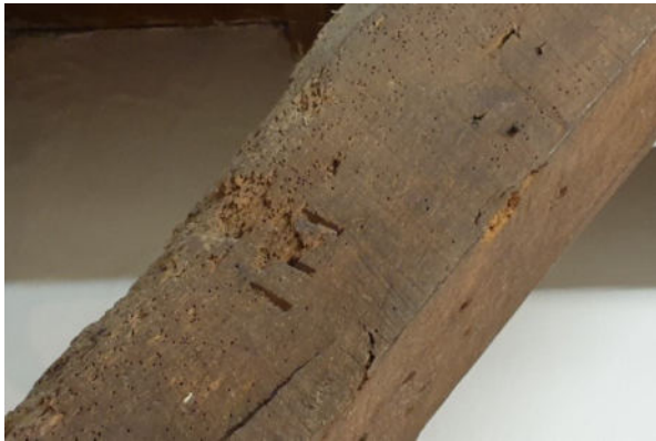
Foto van het gebint voor de muur van de hooizolder met het telmerk III.
