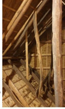
kap van de zaadzolder
