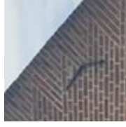
muurankers, vlechting, diverse typen
