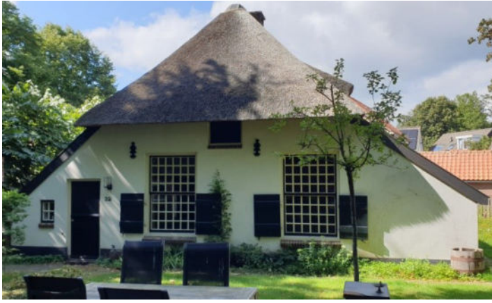
Voorgevel met oorspronkelijk metselwerk onder het pleisterwerk
