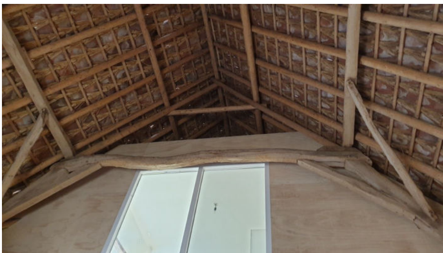
Foto: 2023 constructie van het kapgebint
