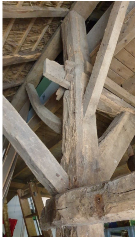
Op de foto van de rechtse korbeel van het gebint van de deel is een I te zien.
