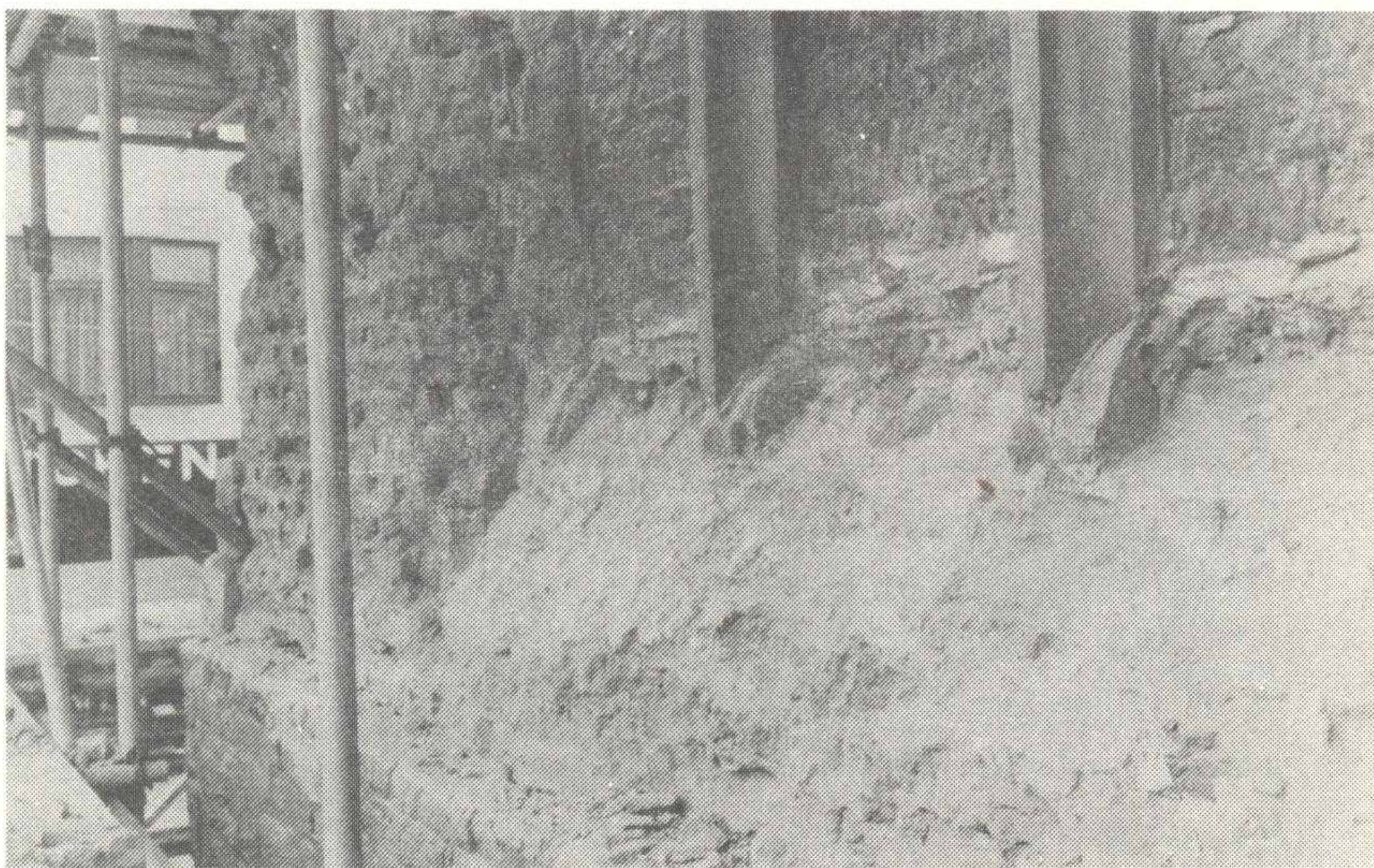
Op deze foto de aanzetten van montants en kantmontants met uitgehakte blokken, die ongeveer 17 cm hoog zijn.
