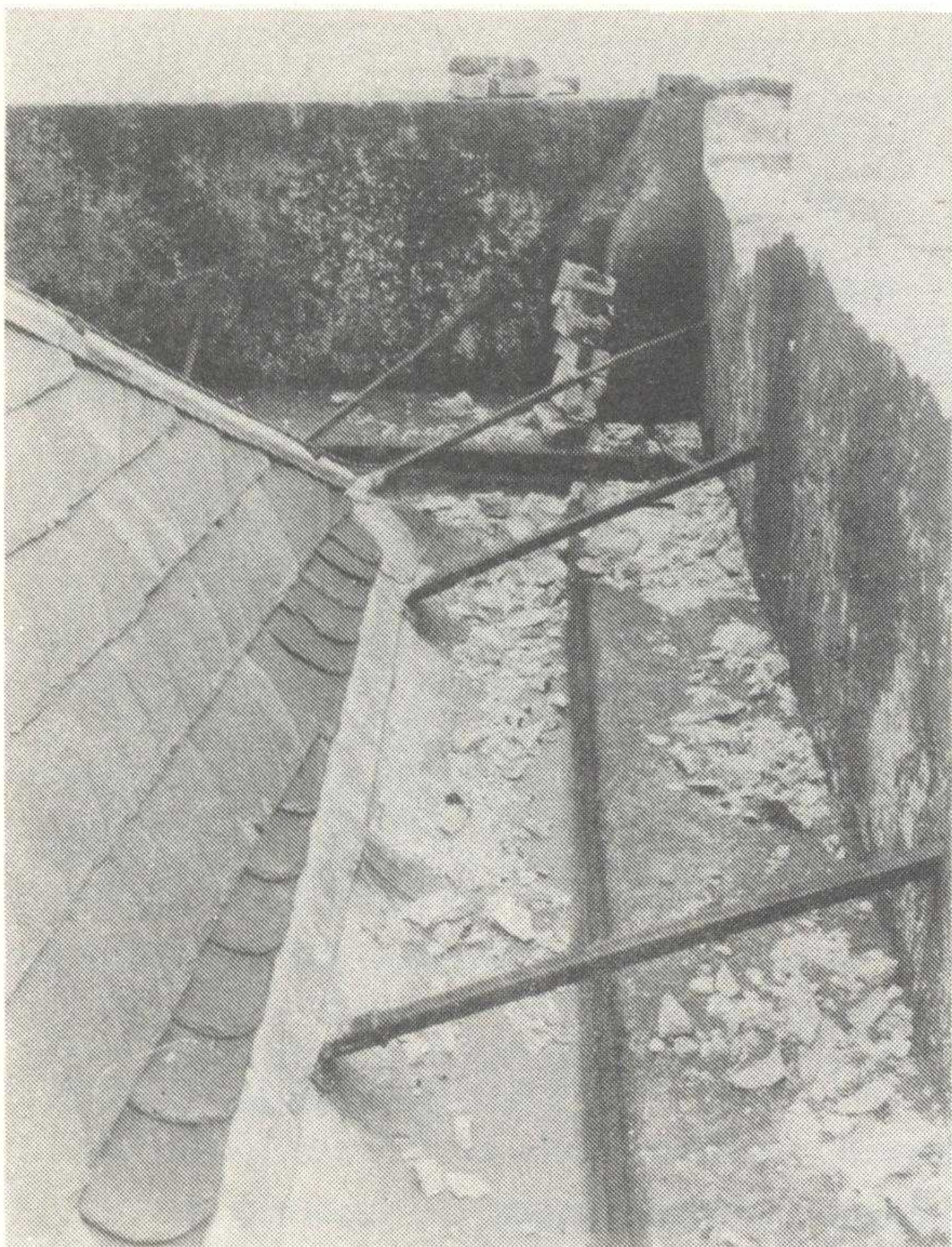
Verankering van de gemetselde balustrade.
