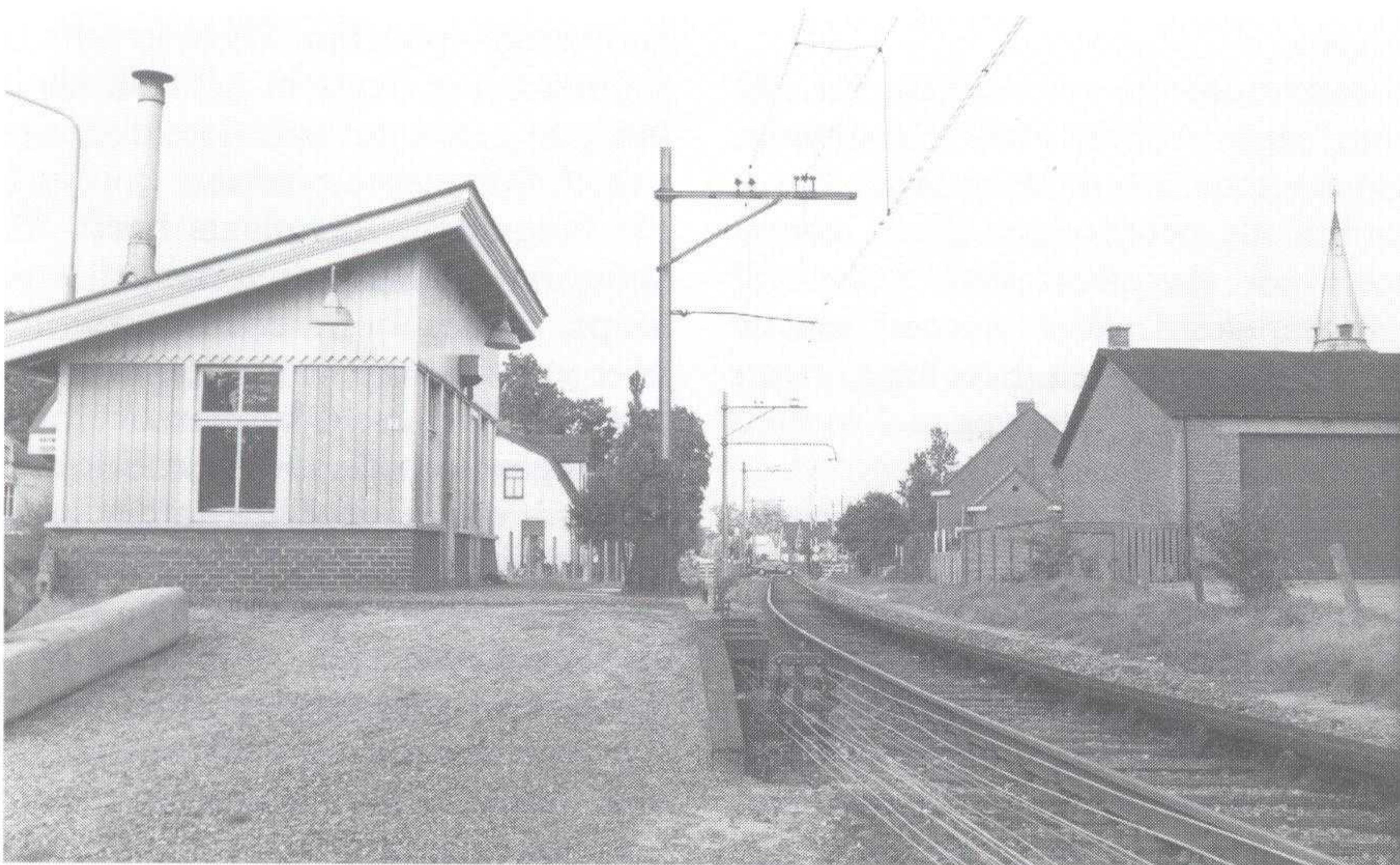
Blokpost ter hoogte van het op pag. 8 genoemde overwegje, nabij "De Bettiekamp". De torenspits van de Noorderkerk is nog juist zichtbaar.
