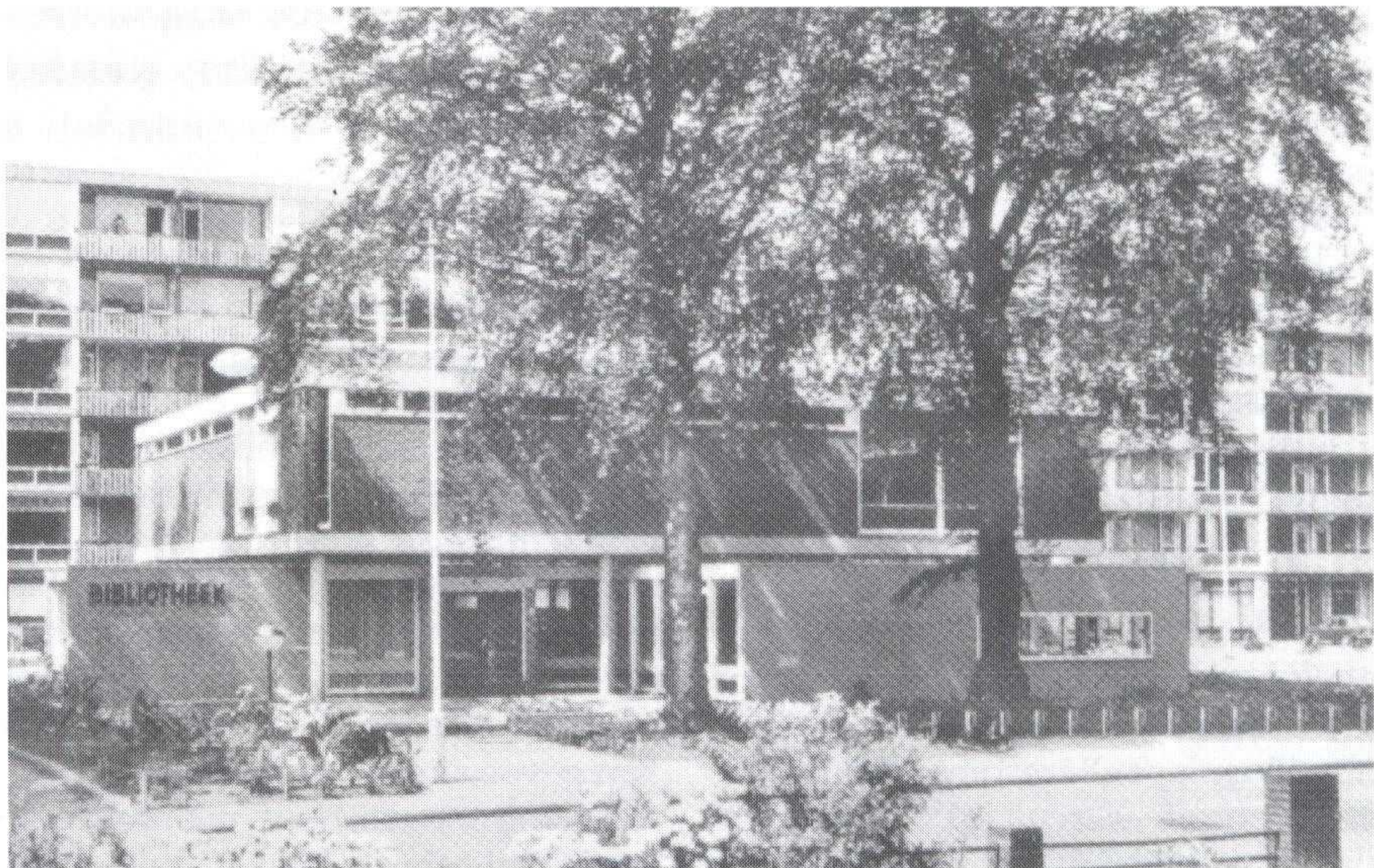
De hoofdbibliotheek aan de Stationsweg te Ede (1968-1997). Jarenlang een vertrouwd en aantrekkelijk gebouw.
