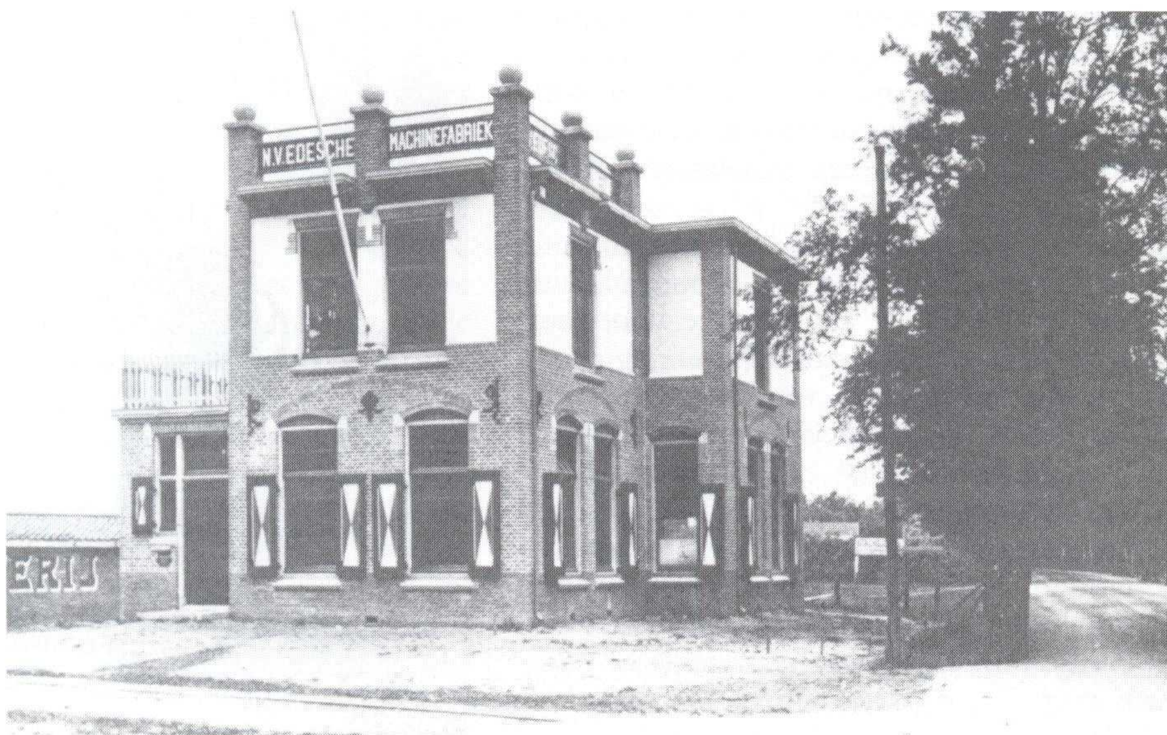
Het kantoorgebouw van de N.V. Edese Machinefabriek. (Foto: Historisch Museum Ede)
