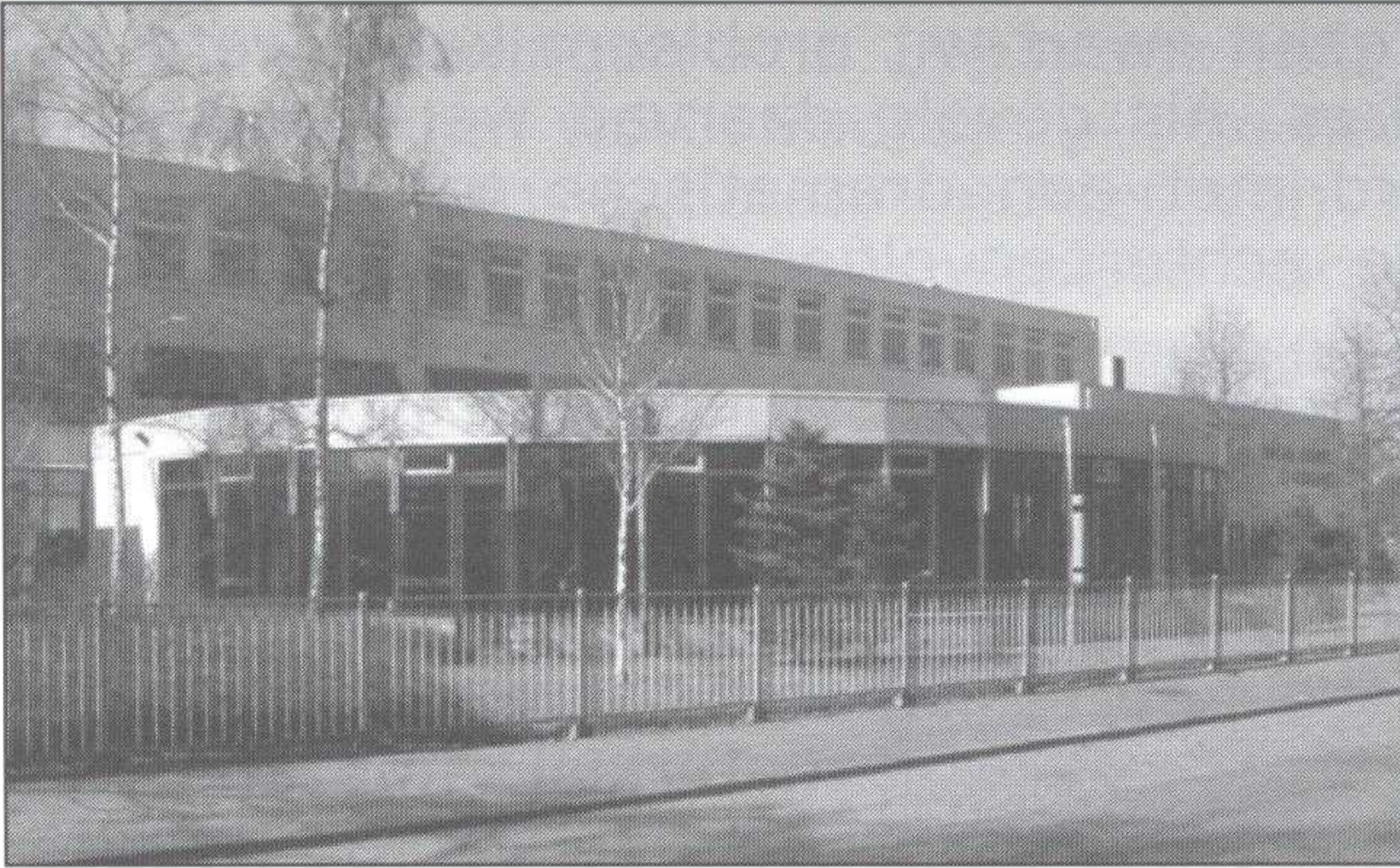
Het gebouw aan de Koekeltse Boslaan
