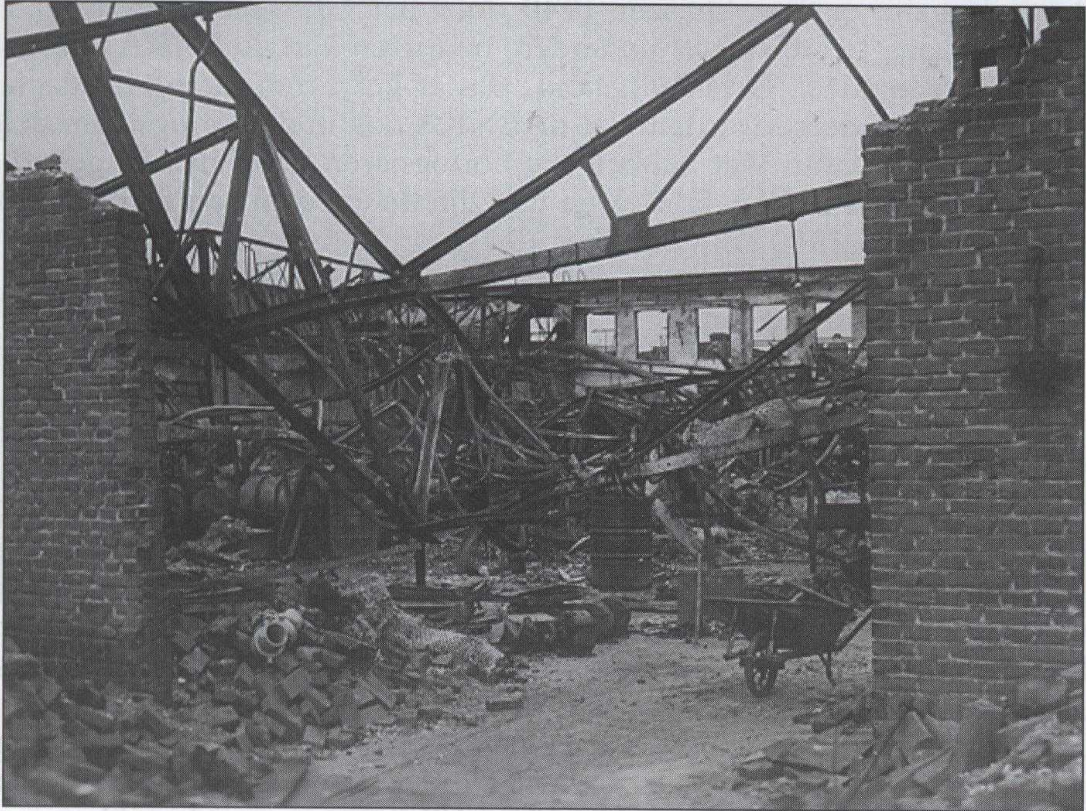
Enka magazijn, oostgevel.
