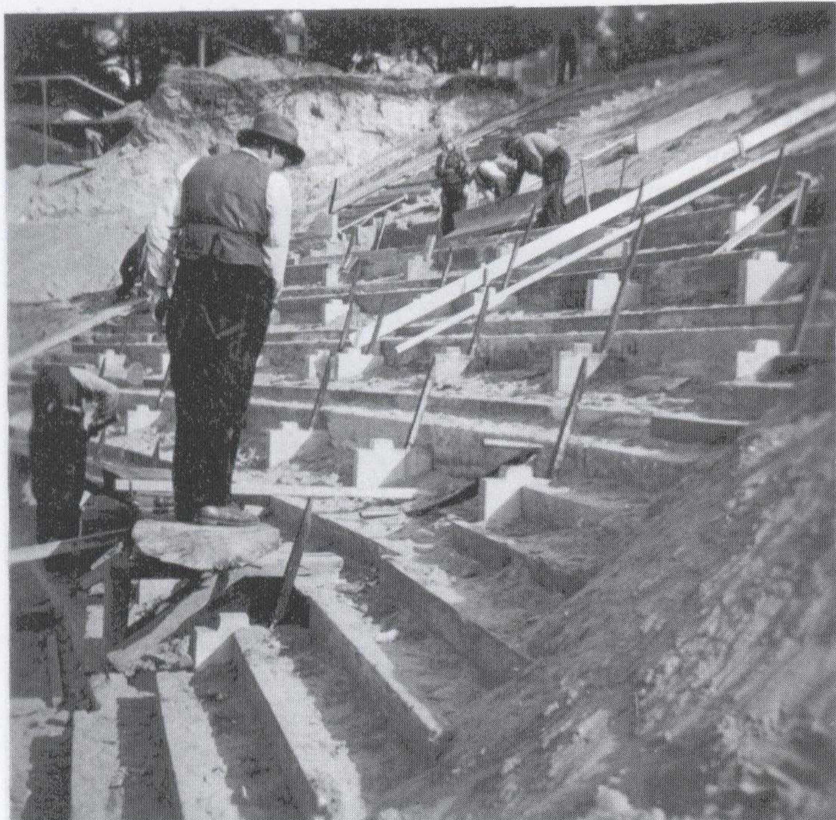
De tribune in aanbouw. De zittingen waren van doorgezaagde beukenstammen.
