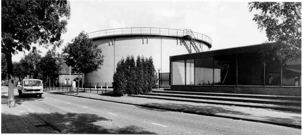
Gashouder aan de Schaapsweg, later omgebouwd tot waterberging
