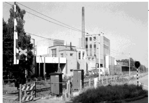
De spoorlijn Ede/Wageningen-Amersfoort gezien vanaf de Kernhemseweg in de richting van Lunteren. Links de bedrijfsgebouwen van Coberco. Opname 1987. (foto GA nr. 10994)
