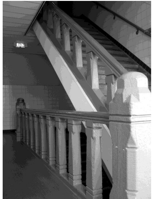
Trappenhuis van beton (foto auteur)
