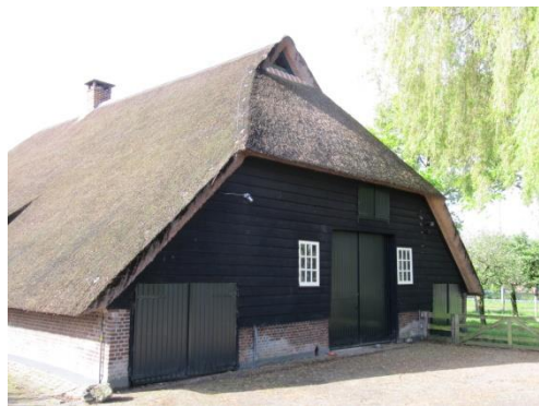
De achterzijde van de boerderij (foto F.G. van Oort, 2012)
