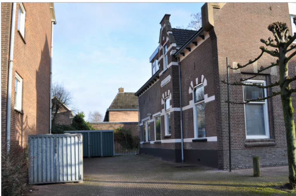
Het voormalige pand van de Spaarbank voor Ede, aan de Notaris Fischerstraat. Volgens Wim Boeve bevond de put, waarvan in de tekst sprake is, zich op de plek waar op de foto de vuilcontainer staat.
