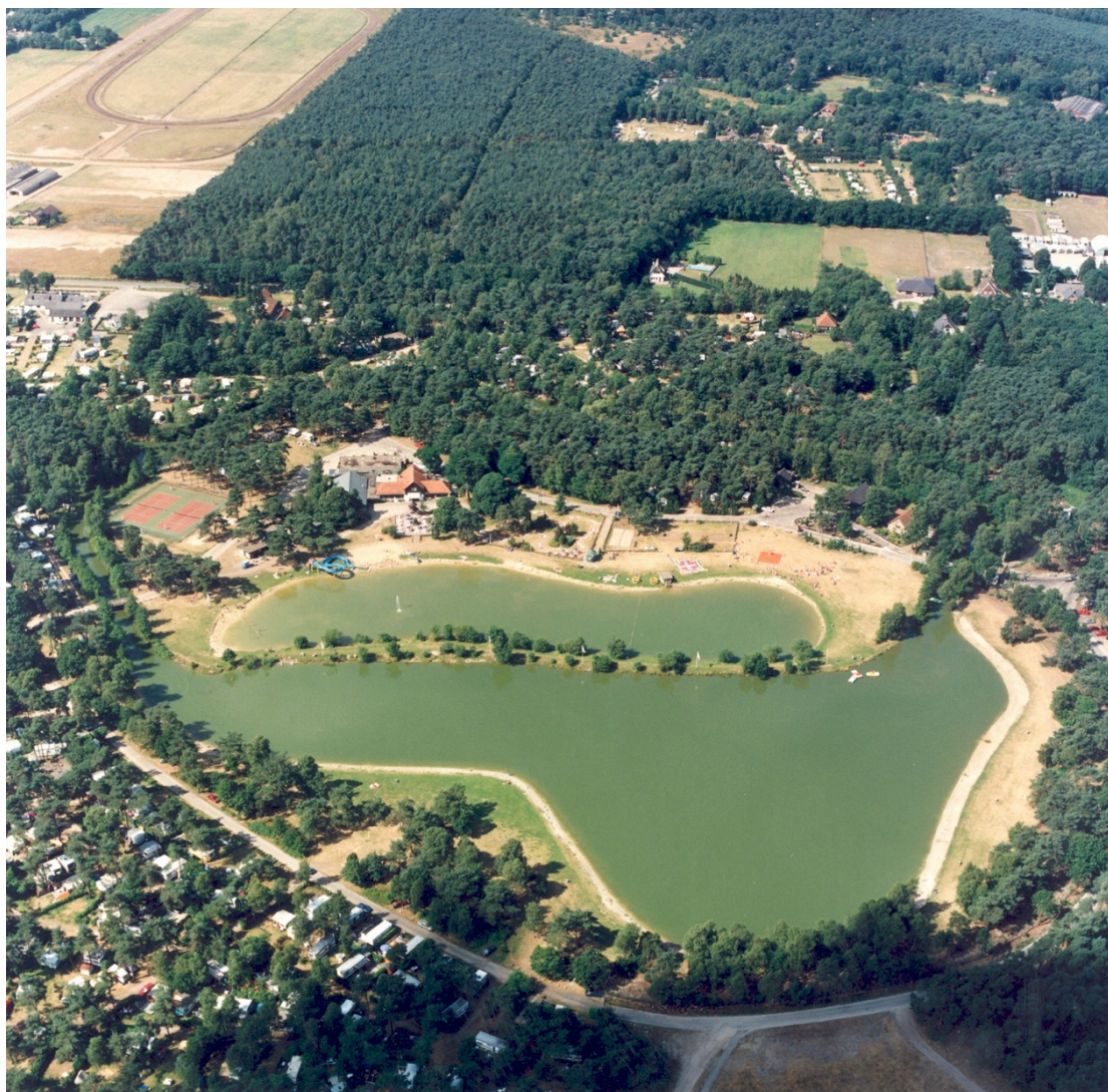
Luchtfoto van het recreatiepark De Zanding te Otterlo. De plas, ooit gegraven in het kader van de werkverschaffing, is duidelijk zichtbaar. Boven de plas loopt de Arnhemseweg, linksboven de daar gelegen renbaan. Aan de onderzijde sluit het natuurgebied aan het park. (Foto A. Ruijs, ca. 1990; GA21645)
