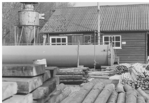
Impregneerketel houtwerf (1990) foto: J. Lub
