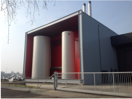
De biomassacentrale aan de Dwarsweg te Ede (foto: J. Lub; 2015)
