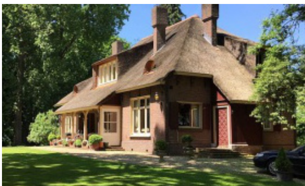
Afb. 6 - H.P. Berlage, Huize Harskamp, in 1913 ‘onthoofd’ en voorzien van een rieten kap
