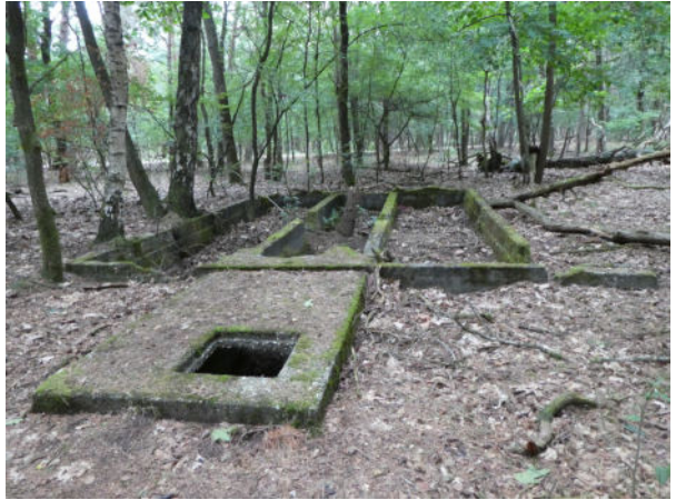
Illustratie 4: Fundamenten van wasgelegenheden
