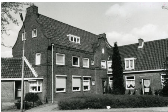
Poortlaan 48 t/m 52. Opvallend zijn de in- en uitzwenkende kopsgevels (foto A. Ruijs, GA 29732)
