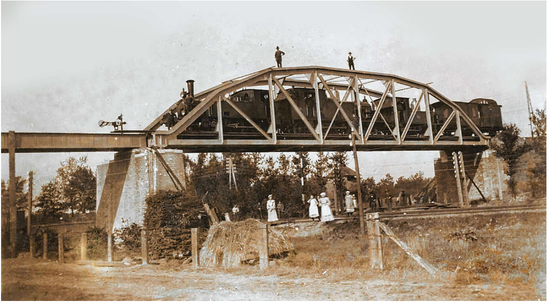
Kippenlijn: Spoorviaduct Stationsweg Barneveld, 30 september 1903 (Barneveldse Courant)
