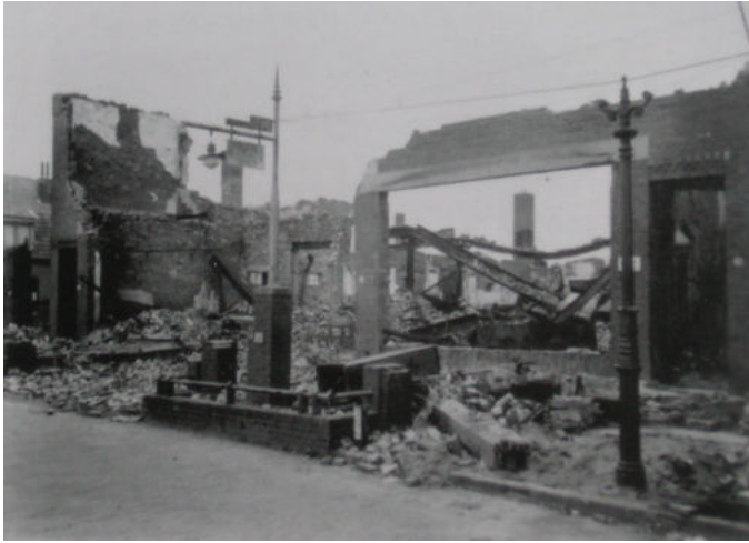
Beschadigde gebouwen in de hoofdstraat te Bennekom (garage v.d. Weerd)
