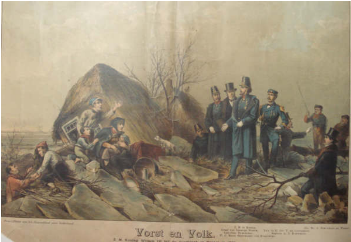
Z.M. Koning Willem III bij de doorgebroken dijk te Brakel. Litho. (Stadskasteel Zaltbommel)
