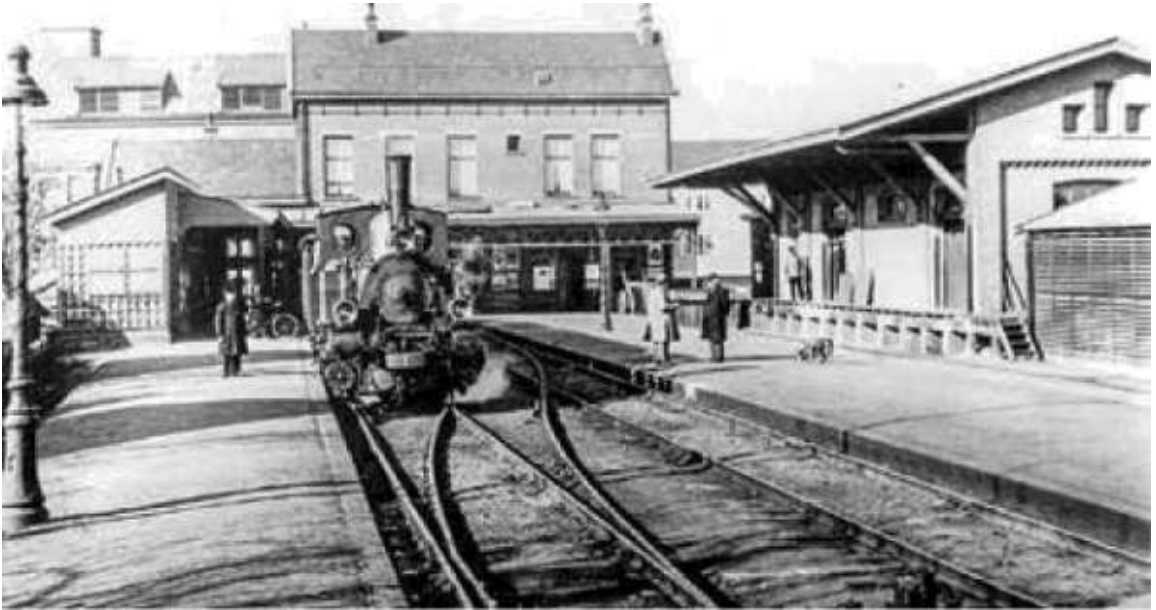
Het kopstation van de tramlijn naar Ede lag lag aan de Stationsstraat in Wageningen. Het emplacement met een locomotievenloods en een rijtuigenloods werd officieel geopend in 1882 en werd gebruikt tot 1937 (Utrechts Archief, collectie De Pater)
