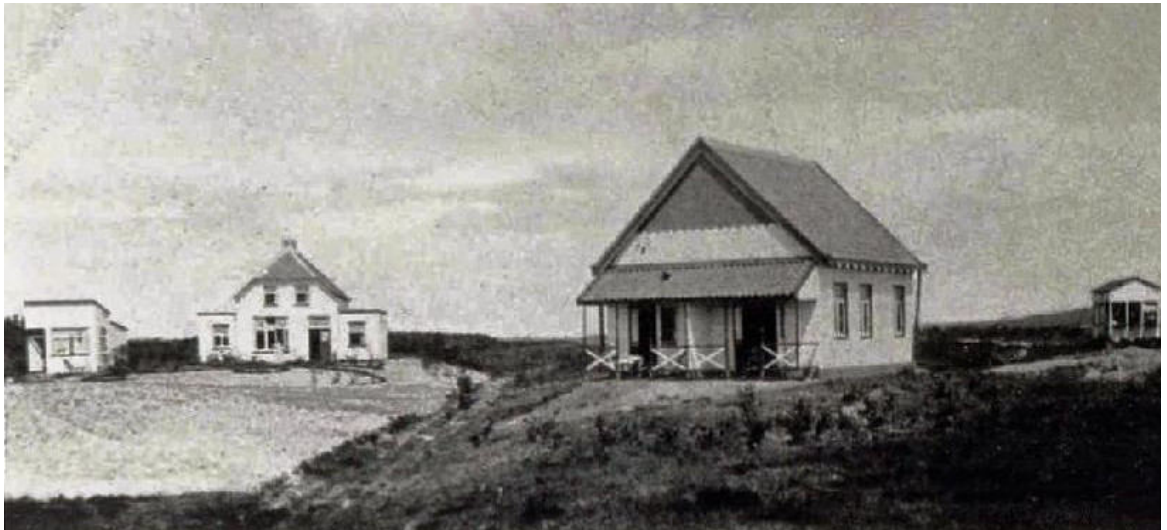
Na alle bouwactiviteiten zag Sunny-Home aan de Van Peursumweg er zo uit.
