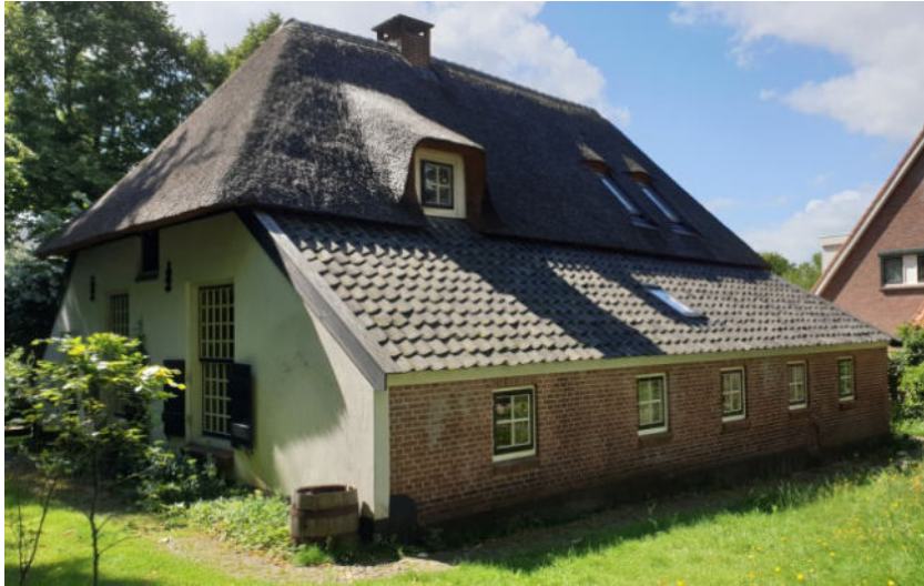
Oostgevel, zadeldak met wolfseinden gedekt met riet en dakpannen
